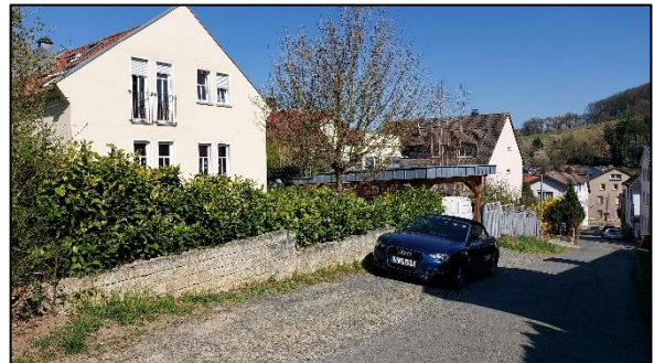
Abbildung 8: Wohnbebauung am Frankensteiner Weg
