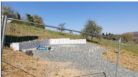
Abbildung 10: Baustelle KiTa westlich von Teilbereich 1
